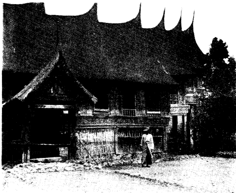
Szapora család lakóháza Alahan Pandjang községben.
