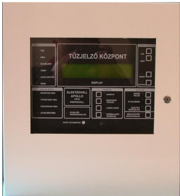
2. ábra TRIDENT-J-NET 002 két hurkos tűzjelző központ
