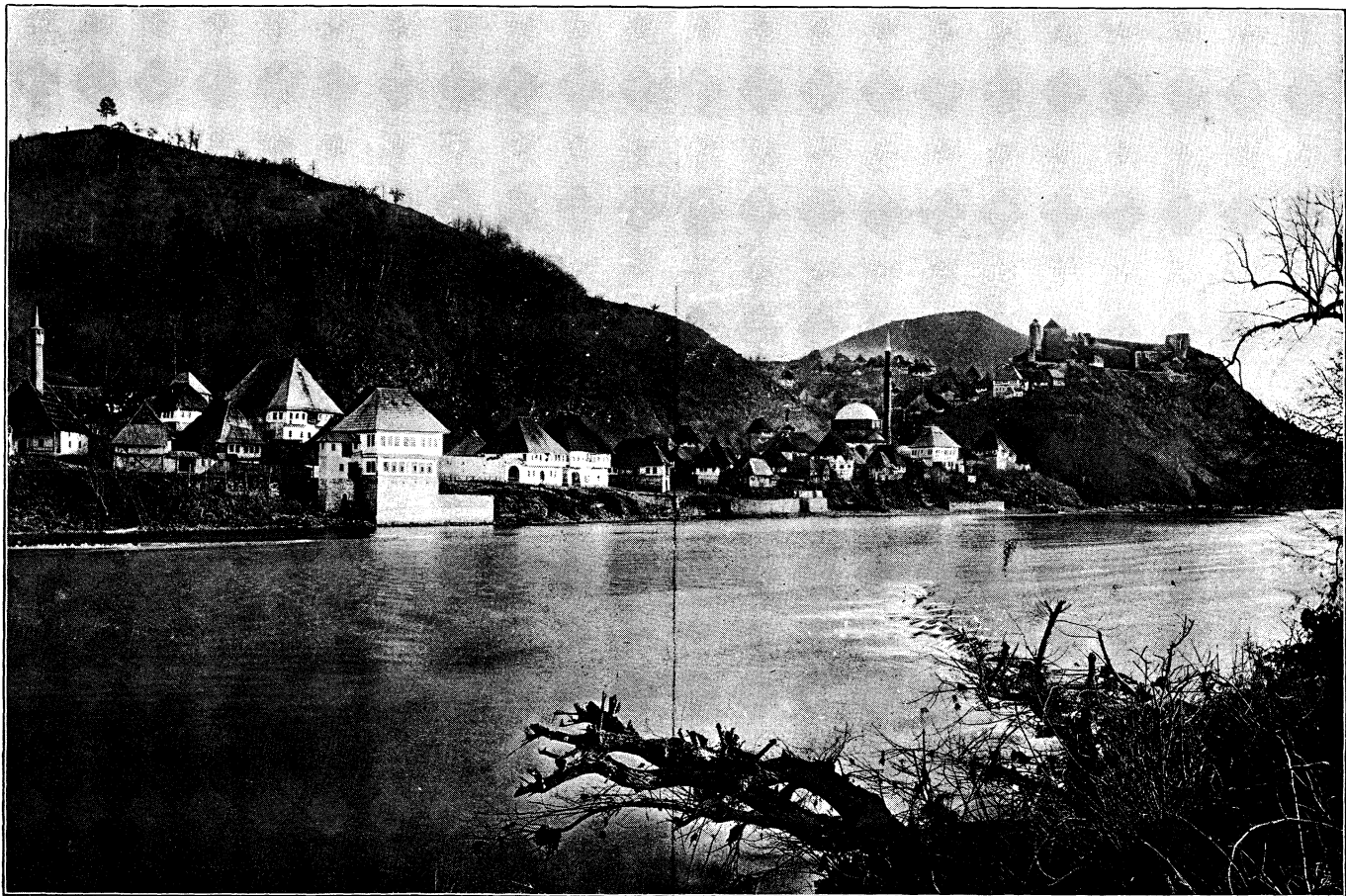
Maglaj von der Nordseite.
