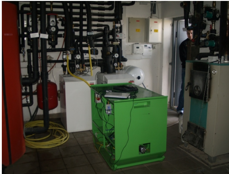
26. ábra TRT berendezés bekötése a hőszivattyúk helyére, MEAK
