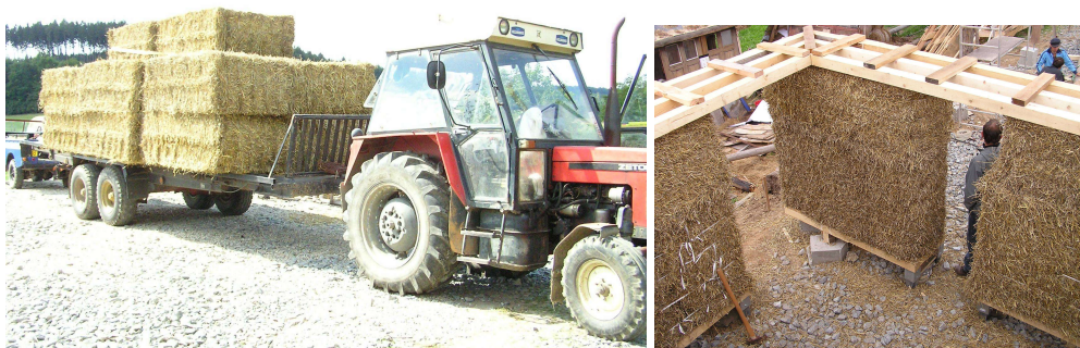
19. ábra. Balra: Nagyméretű kockabálák szállítása a beépítés helyszínére. Jobbra: Nagyméretű kockabálák felhasználásával készülő kísérleti épület Csehországban. (saját fotók)
