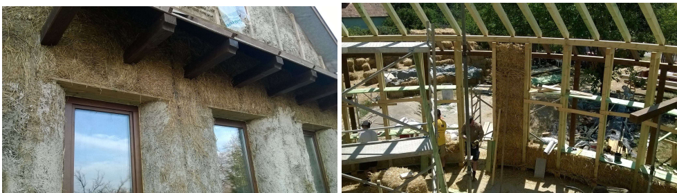
3. ábra. Természetes anyagok (fa, szalma, vályog) használata egy szegedi szalmaháznál (Igaz, 2014c). Balra: homlokzat, íves falsarokkal, első réteg külső vakolat készítésekor. Jobbra: bővítmény készül fa tartószerkezettel és szalmabála kitöltő falazattal.
