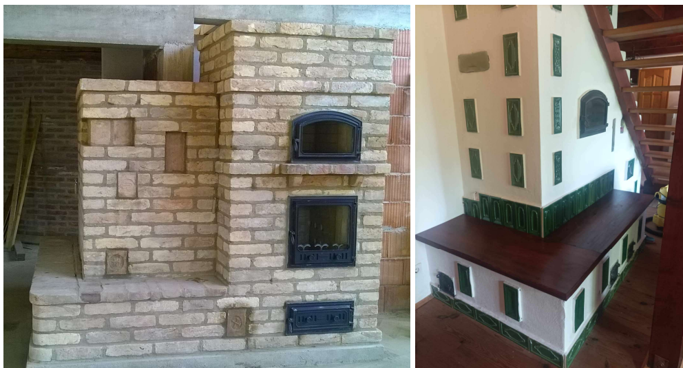
23. ábra. Balra: Szegedi szalmaházba épített multifunkciós tömegkályha. (Igaz, 2014c) Jobbra: Debreceni dupla soros szalmaházba készített multifunkciós tömegkályha: főfűtés, fűtött padkával, sütés-főzési opcióval, HMV és vizes oldali fűtési képességgel. (Igaz, 2017a)
