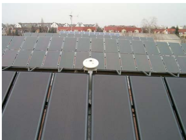
2. ábra. Siemens ST 40w, Kyocera KC 120 w, Dunasolar DS 40w napelemek elhelyezése
