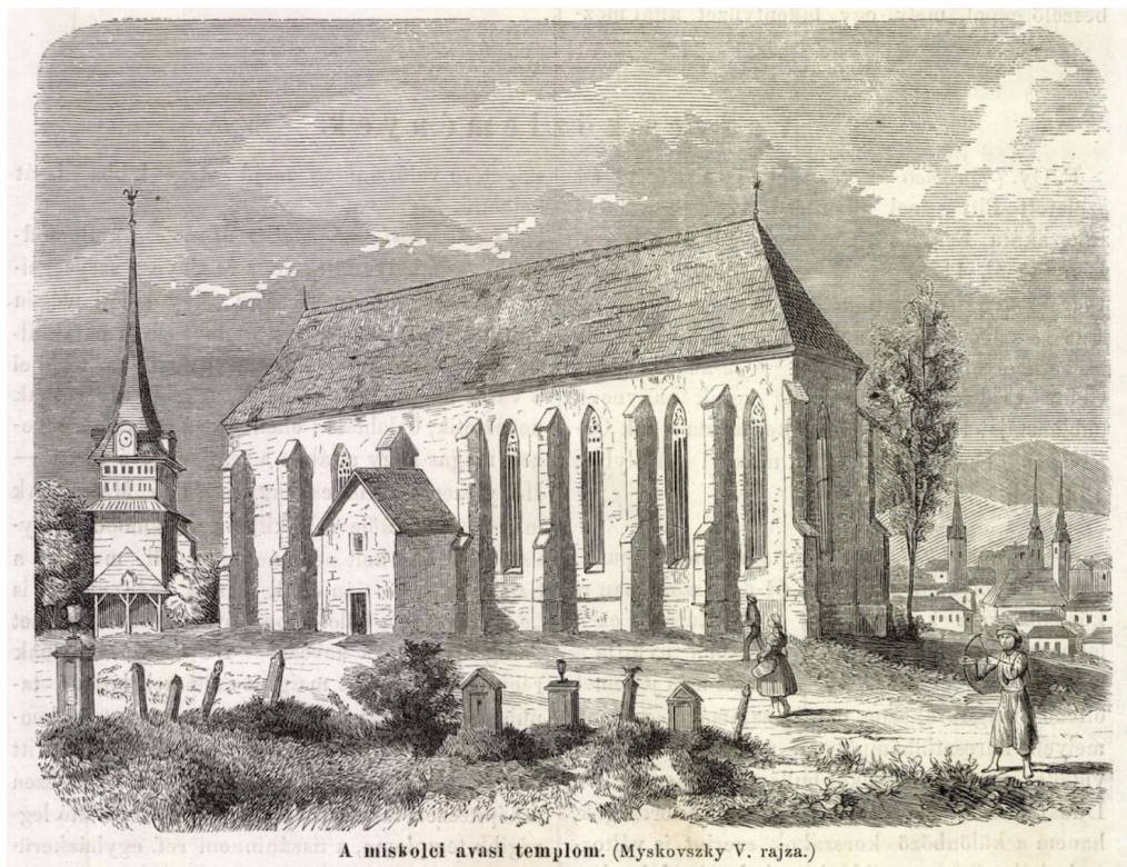
4. ábra. Myskovszky Viktor metszete az avasai református templom déli homlokzatáról. Forrás: Myskovszky 1868. 352
