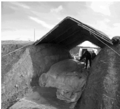
3.2.2. ábra: A vizsgált tárolócellák betonfödémig eltávolított fedőréteggel
