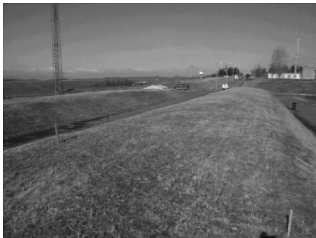
3.2.1. ábra: A fedőréteggel ellátott, lezárt tárolócella sor
