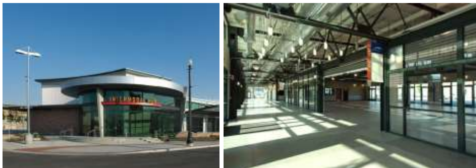
A Salt Lake City Intermodal Hub épülete kívülről és belülről
