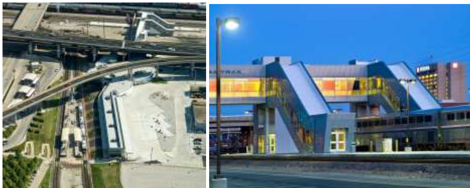
A Gateway Multimodal Transportation Center madártávlatból és a vasúti síneken átívelő utasforgalmi csápok
