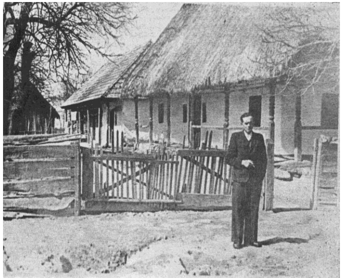
24. kép. Módos gazda háza, melyet a „régiek” elmondása szerint a 18–19. században építettek. Ez egy tölgyfatalpas, vert falú, szabadkéményes, zsúpfedeles, háromosztatú ház. Az udvar deszkakerítéssel van körülveve. (Fotó: Bocskor Áron, Öregakli, 1942)
