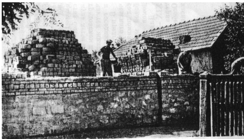
Рис. 72. Современное строительство дома из саманных кирпичей. Село Новое Клиново Виноградского р-на. Фото Г. Спирина
