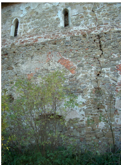
4. kép Eltérő falazástechnikák
