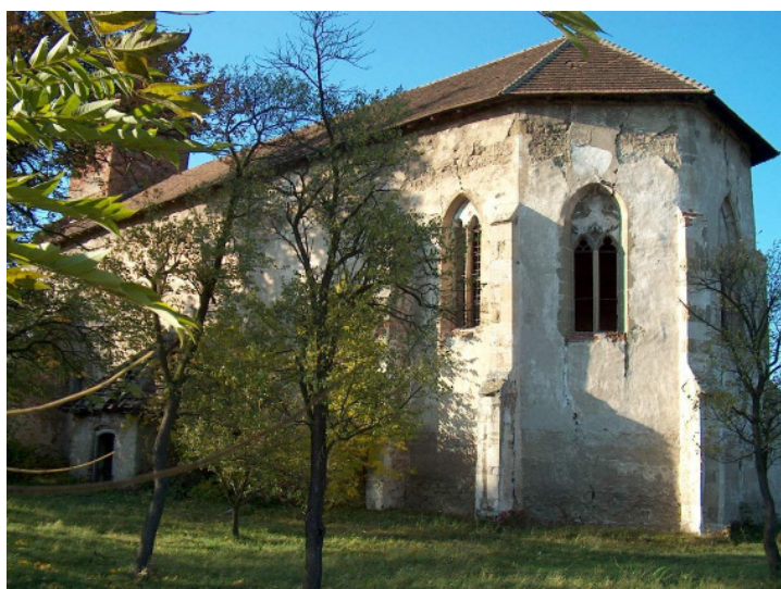
7. kép Sokszögű szentélyzáródás
