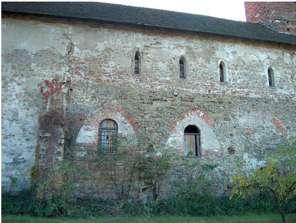
3. kép – A főhajó északi oldalfala a befalazott gótikus ívekkel
