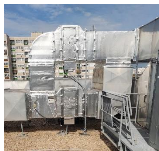
3.15 ábra a, beépített evaporatív hűtőfal b, a légszűrő rendszerbe beépített evaporatív léghűtő berendezések
