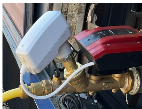
4.25 ábra a, szabályozó rendszer elvi séma; b, rendszerbe beépített ultrahangos áramlásmérővel felszerelt okos szabályozó szelep
