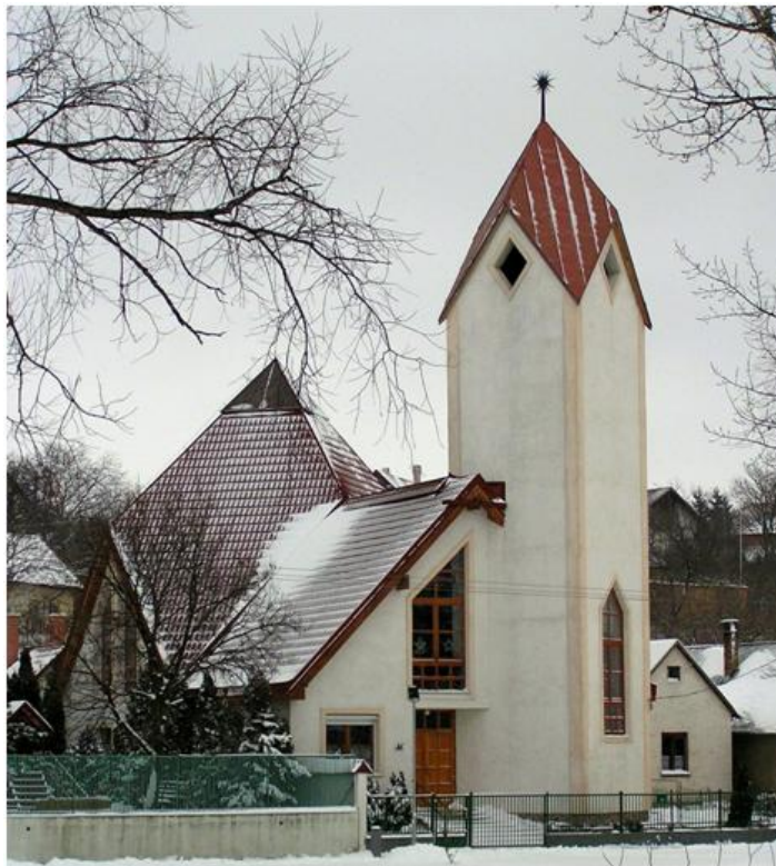
29. ábra. Síklapokból összeállított tetőhéjalások
