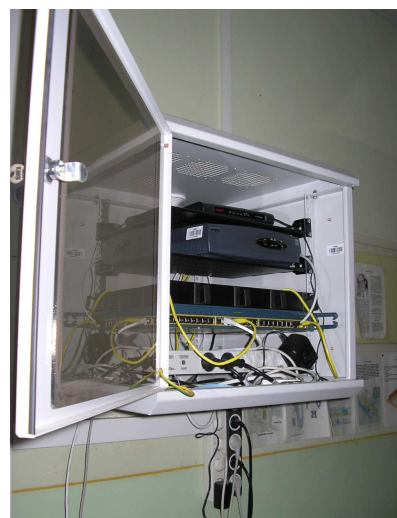
3. ábra: Az Internet-csatlakozás végpontjai a 23-as teremben
