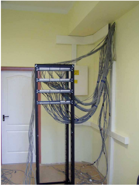
7. ábra: A végpontok bekötése folyamatban
