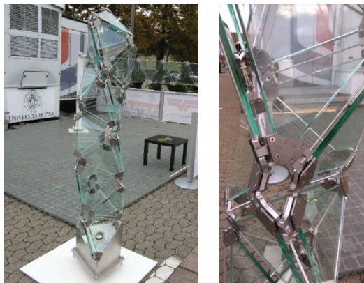
14. ábra Térbeli üveg elemekből felépülő oszlop. Fig. 14. Column made up from spatial glass elements.
