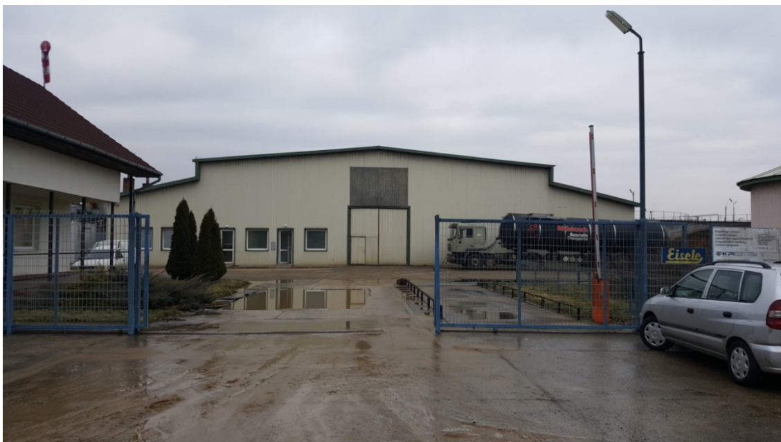
Pictures 1–2. The Nyírbátor Regional Biogas Plant
