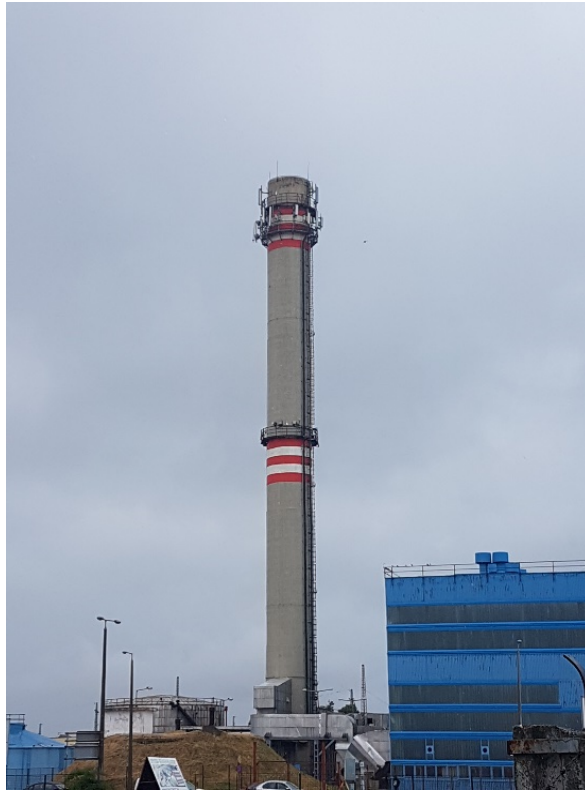
3.12. ábra Vízszintes piros-fehér akadályjelölés egy magas kéményen, amely előírásoknak megfelelő akadályvilágítással is rendelkezik
