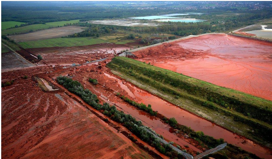
App. 10. ábra. Az ajkai timföldgyár vörösiszap-tározójának átszakadt gátja (Forrás: www.sikerado.hu )
