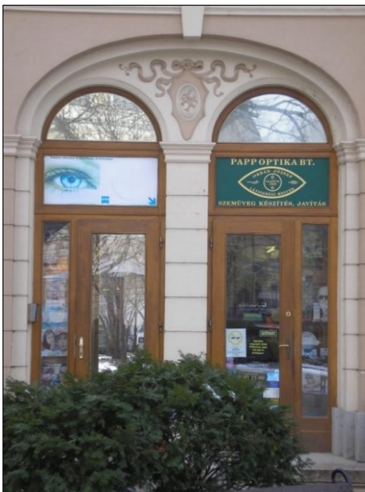
Piac utcai portál rekonstrukció
