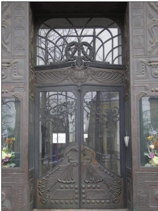
Első Takarékpénztár épületének egyik helyreállított portálja
