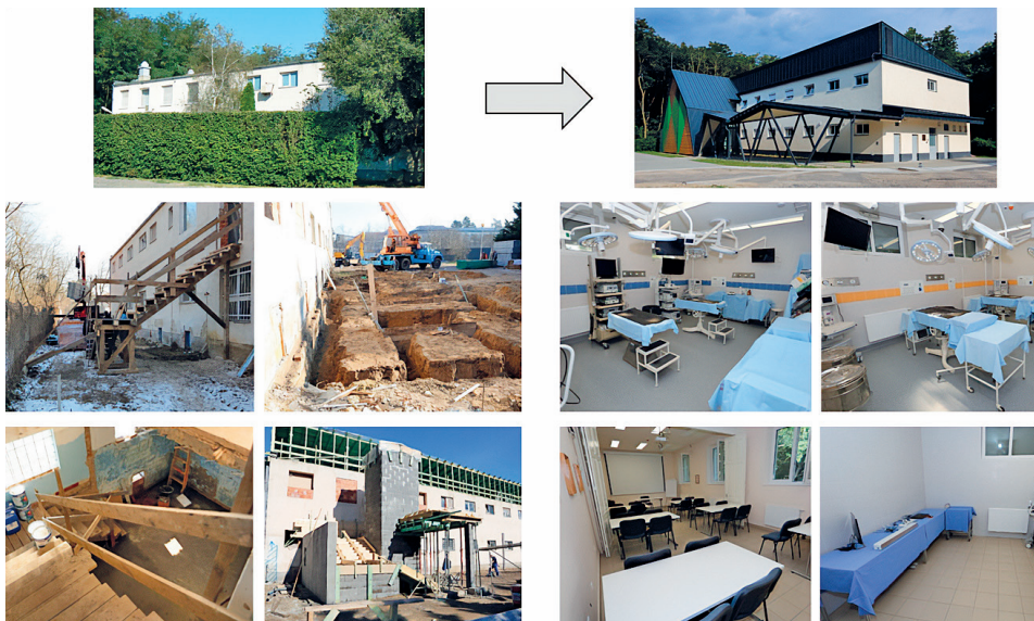
Válogatás a Sebészeti Műtéttani Tanszék „B” épület komplett rekonstrukciója munkafolyamatáról és a megújult épületről és helyiségeiről készített fotókból
