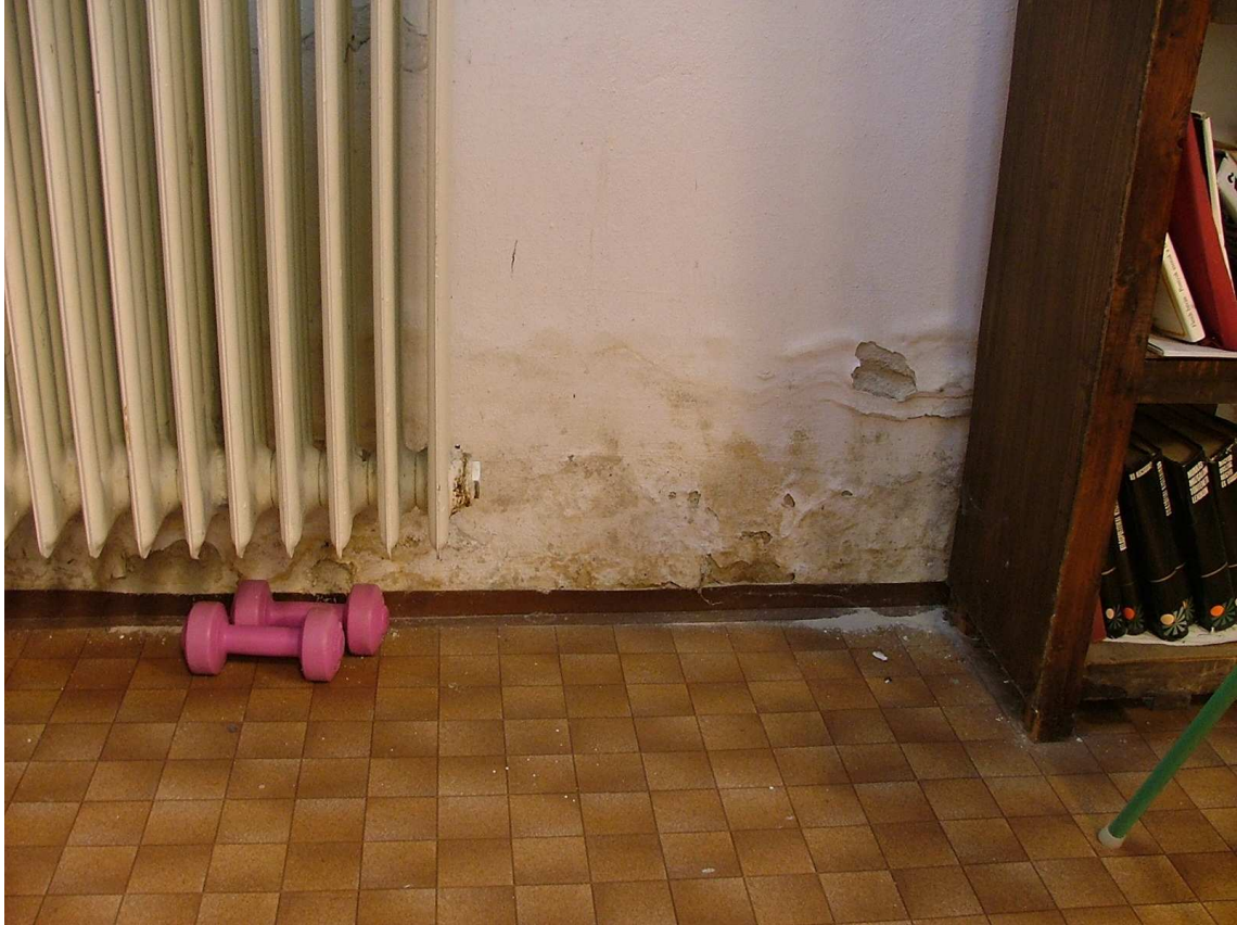
2. KÉP VÁCKISÚJFALU KÖNYVTÁRA A FELÚJÍTÁS ELŐTT
