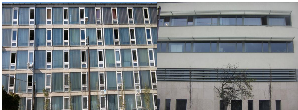
4.21. A vizsgált épület K-i homlokzata a felújítás előtt és után
