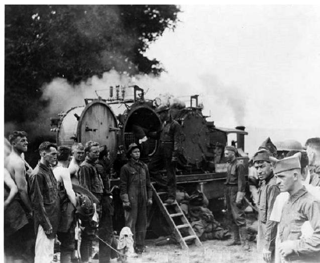
4. ábra | Teherautó-alvázra épített, Thresh-féle alacsony gőznyomású mozgó sterilizálóállomás. Az amerikai katonák sorban állnak ruháik fertőtlenítésére. (A fotó az Imperial War Museum [London] tulajdona)
