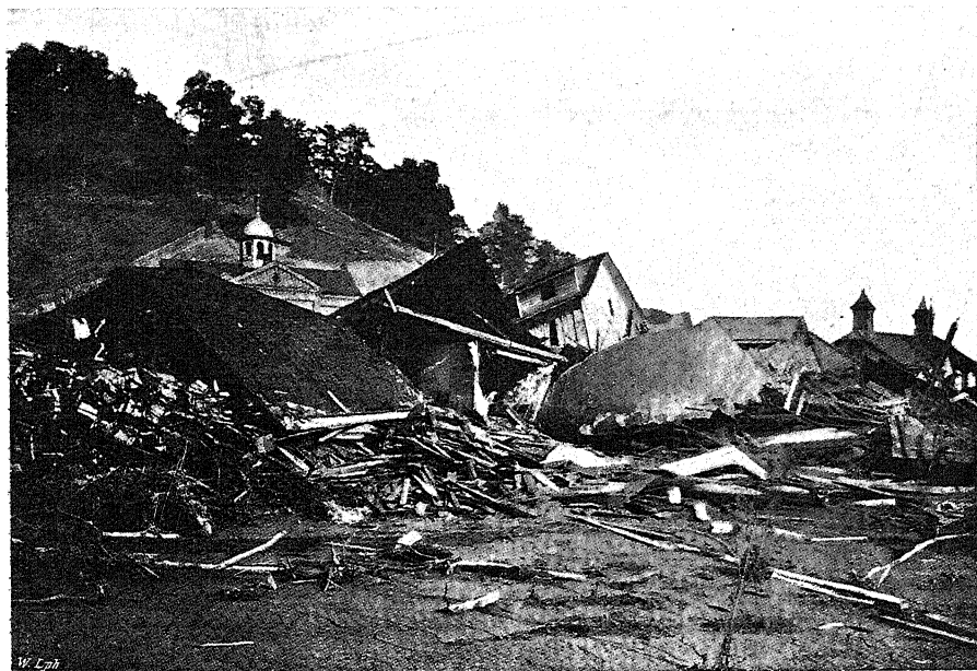
A perrégauxi gátszakadás pusztításai.
