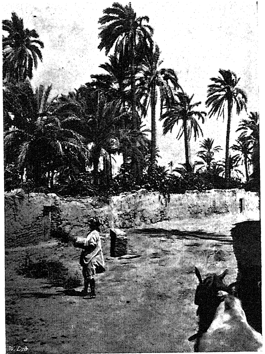
A sidi-okbai építőmester.
