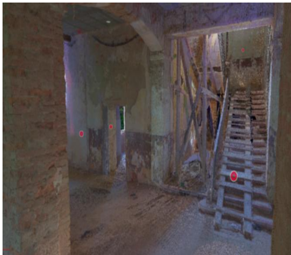
60. ábra: A fotó és a szkennerral felmért lépcsőház pontfelhője (saját szerkesztés 2024)
