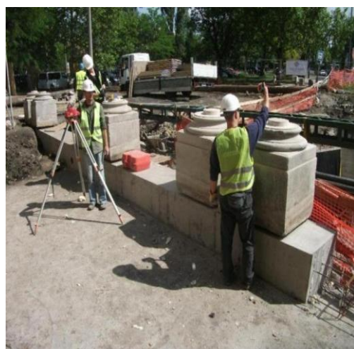
63. ábra: Lézer használata a terepen, Helvét farm és békéscsabai pályaudvar 8 oszlopos portikusz építése (forrás: saját fotó)
