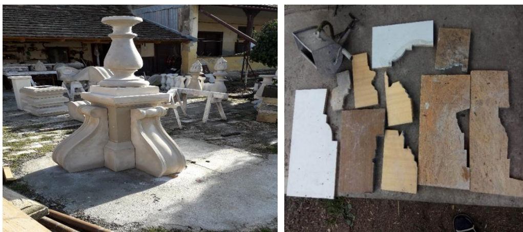
38. ábra A kápolna felújítás közben, díszek és sablonok (forrás: Szolga K 2021.)
