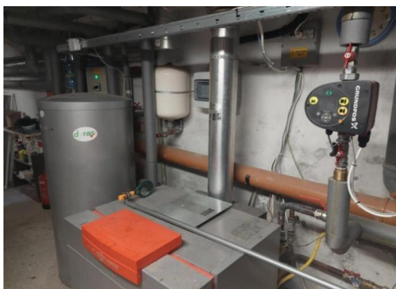
71. ábra: A geotermikus hőközpont kialakítás az épület pincéjében, (forrás: saját szerkesztés)
