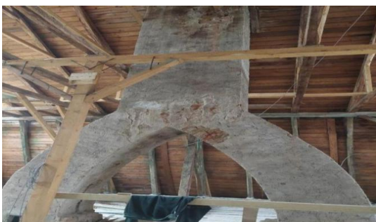
27. ábra: Egyesített („közös”) kémény és „mester földemgerenda” a kastély padlasterében (forrás: saját fotó 2022)
