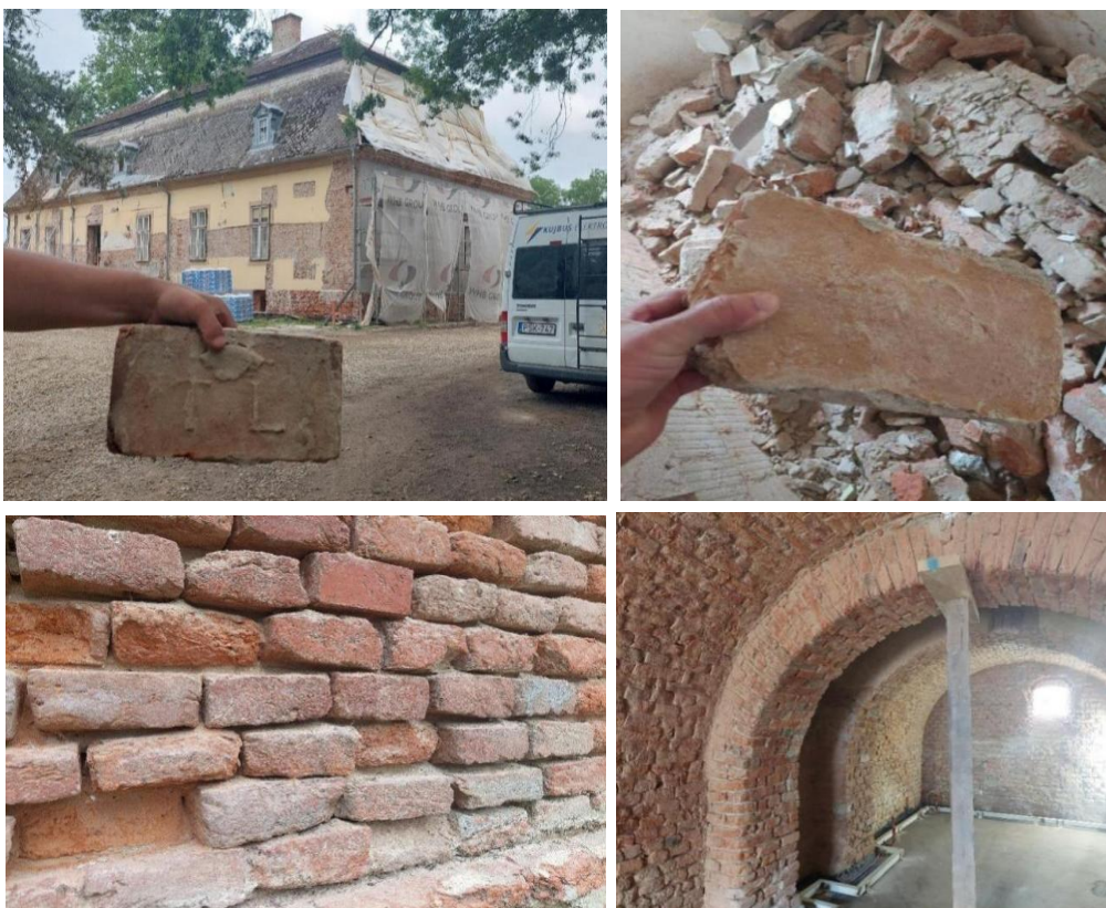
29.ábra: téglá építőanyag mintavételek (forrás: saját fotók 2022)
