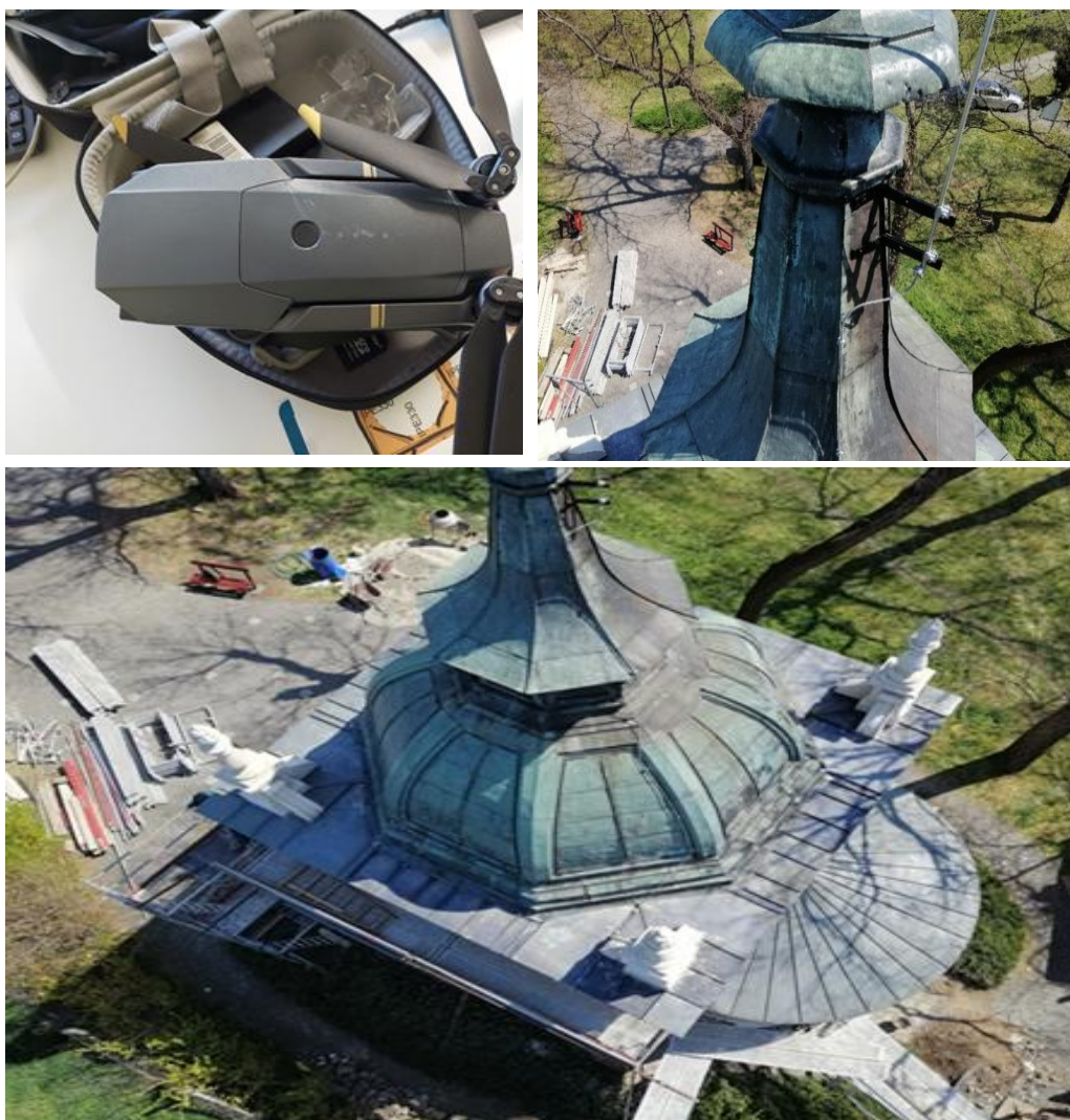
65. ábra: A Batthyány-Geist kastély kápolna felújításnál az állapotfelmérésnél használt drón (forrás: saját fotók 2021)
