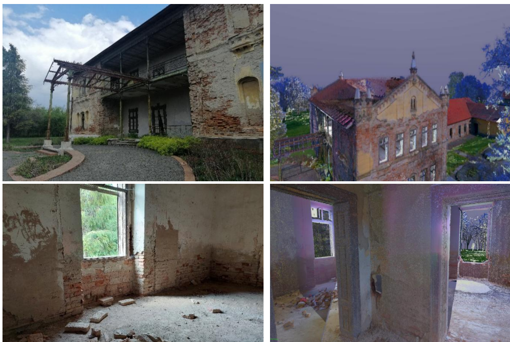
62. ábra: A kastélyépület homlokzatának és belső tereinek felmérése (saját fotó és szerkesztés 2024)
