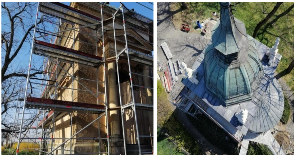
37. ábra A kápolna felújítás közben (forrás: Szolga K 2021.)
