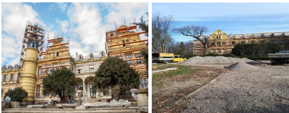
9.ábra: A fő homlokzat rekonstrukciós munkái (forrás: saját fotók 2021)
