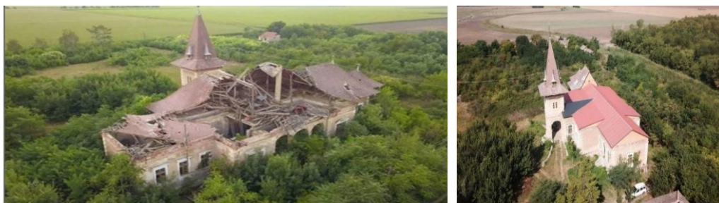
52.ábra: A kastély tönkrement tetőszerkezete és állagmegóvása (forrás: Leszenyiczki Pál)
