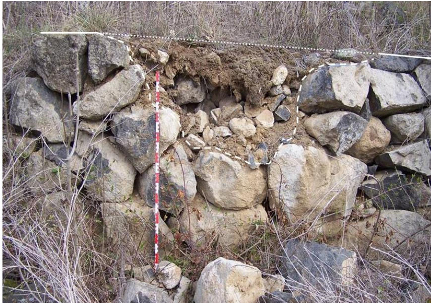
29. ábra Részben leomlott támfalszakasz a tokaji Nagy-hegyen (Novák és Incze, 2014)
