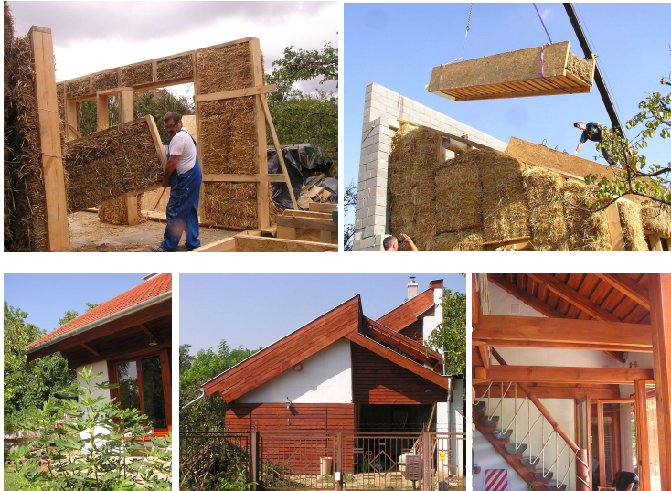
2. ábra. Magyarország első szalmapanel háza. Felül: Kivitelezés közben készült képek. Alul: Elkészült ház látványa (saját fejlesztés, saját fotók)
