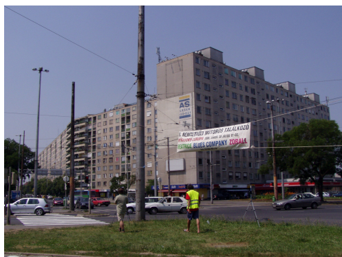
2. kép: Panelházak a Csapó utcán
