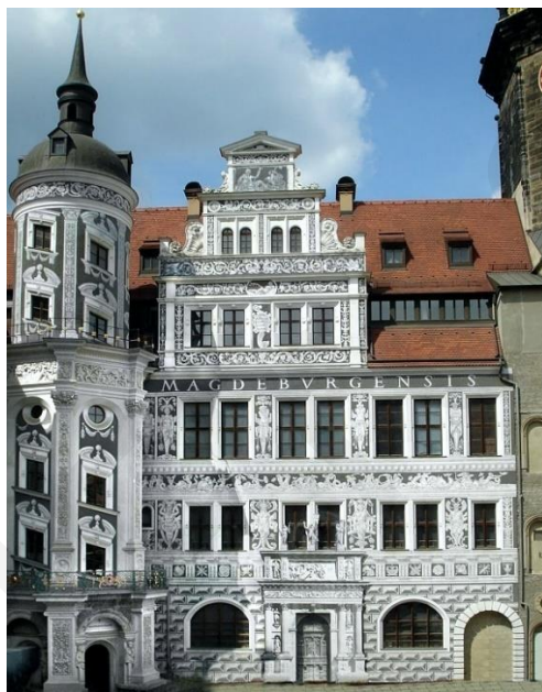
84. A drezdai kastély sgraffitoval díszített Kápolna szárnya
