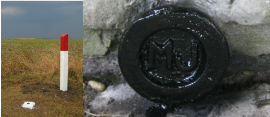
3.2. ábra. Egy külterületi III. rendű magassági alappont, felhívó jellel és egy belterületi I. rendű pont, falicsappal állandósítva
