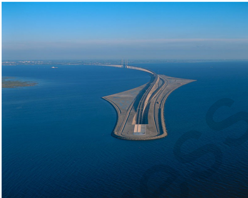
1.1. ábra. Dániát és Svédországot összekötő híd, ami az utolsó 4 km-en a tenger alatti alagútban folytatódik
