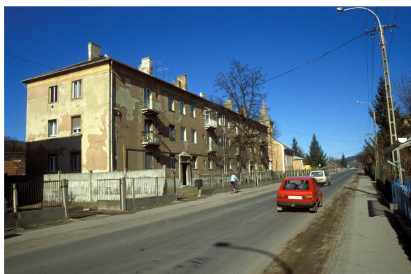
33. ábra. 1950-es években épült kolóniaépület.
