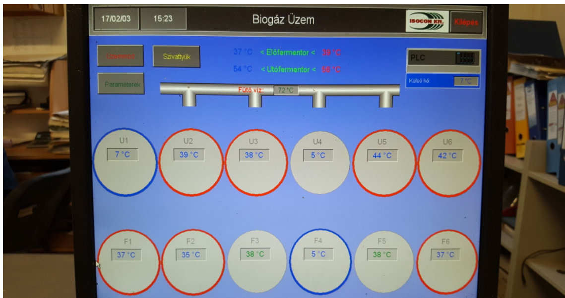
11. kép: A bioreaktorok automatikus fűtésvezérlése (Nyírbátori Regionális Biogáz Üzem, 2016)
