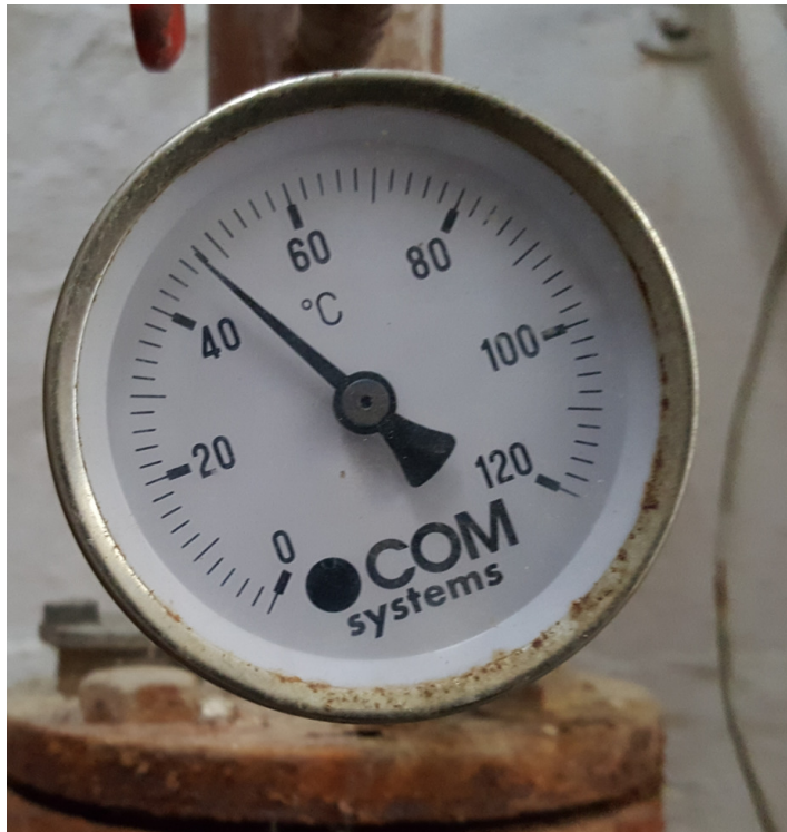
10. kép: A bioreaktorok fűtésrendszerének 2. számú hőmérsékletmérő egysége (Nyírbátori Regionális Biogáz Üzem, 2016)
