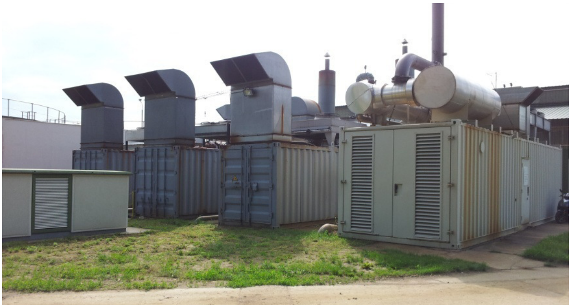
7. kép: A blokkfűtő erőművek konténerekben (Nyírbátori Regionális Biogáz Üzem, 2016)
