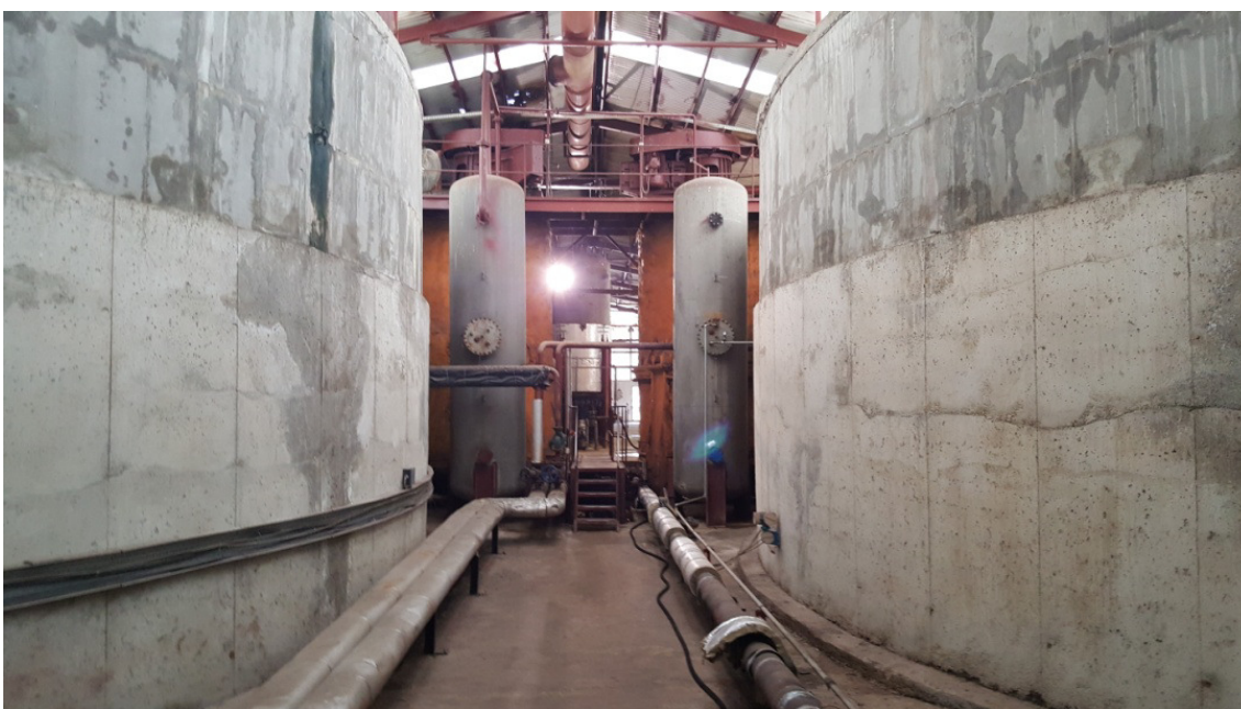
5. kép: A bioreaktor fűtési rendszere (Nyírbátori Regionális Biogáz Üzem, 2016)
