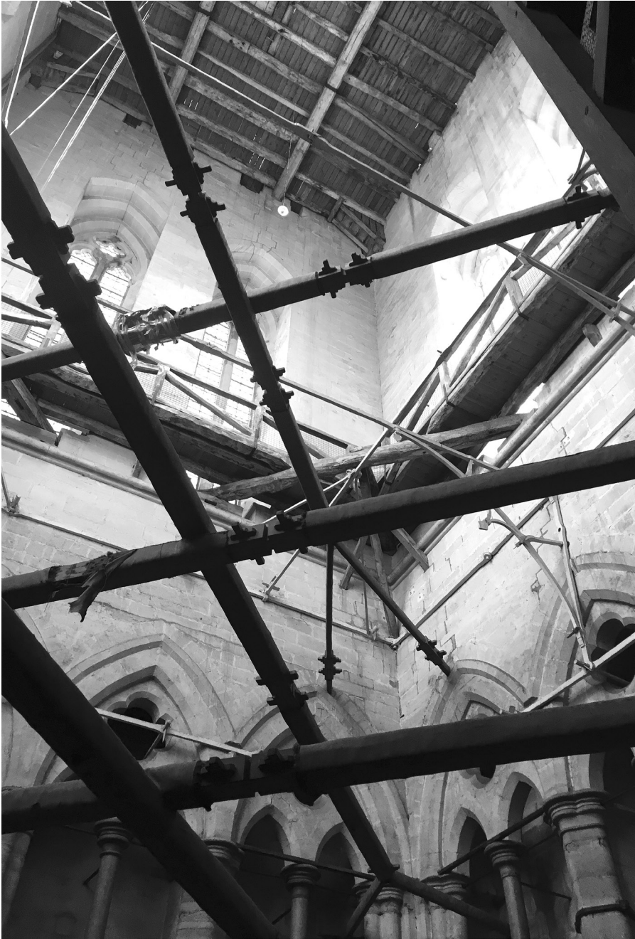
21. kép – A salisbury-i torony négyzetes szintje belülről, a kiegészítő fémszerkezettel
