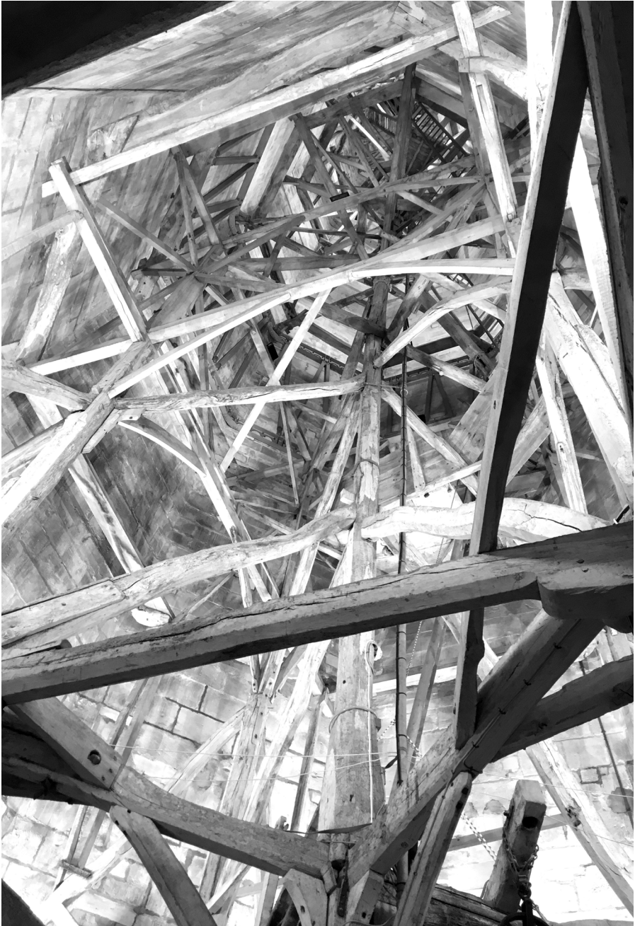
19. kép – A salisbury-i sisakban lévő állvány
