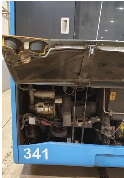
11. ábra. BRQ4/10/35 TFH típusú fékkompresszor elhelyezkedése a GST 12 típusú járműben
