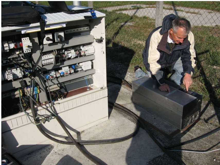
1. kép: Frekvenciaváltó beépítése, és a vizsgálat
