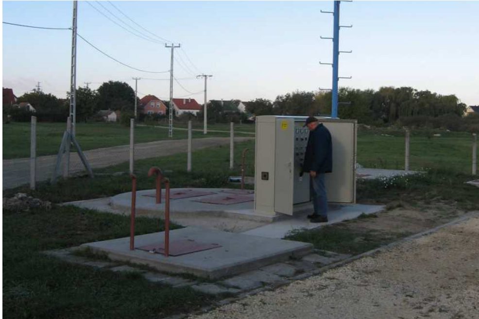
33. ábra: „Tordai” átemelő és vezérlőszekrény
