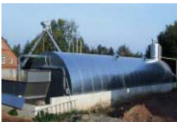
6. melléklet. Külső kéntelenítéssel és gáztároló térrel ellátott fekvő csőfermentor ( Bayerisches Landesamt für Umwelt, 2004 nyomán )
