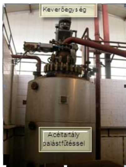
14. ábra. A Tycoon tartály és a szerelvényei (Saját forrás)
