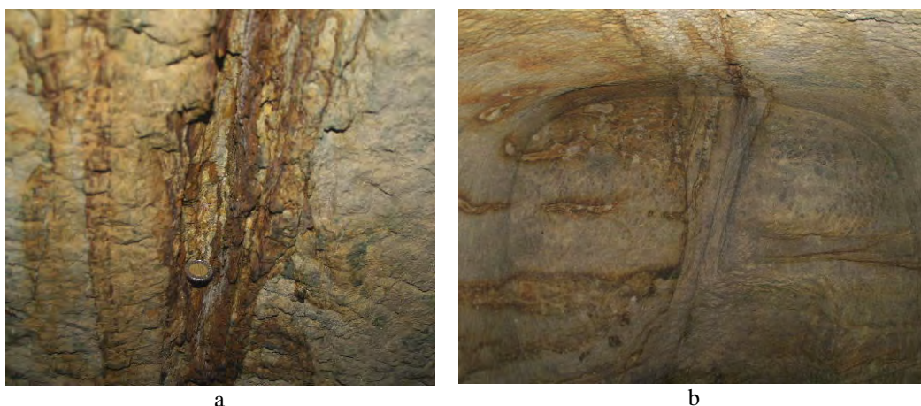
7.8.7. ábra: A Nagyavas Alsó-sor 726. sz. pincéjét harántoló törés- és vetőraj fotófelvétele a főtében (a) és a pincevégen (b) homokos bentonit összetétele limonitos sávózással
