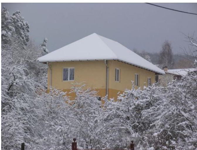
42. ábra Közel nulla energiafelhasználású épület, Napraforgó ház, Isaszeg és Pécel között
