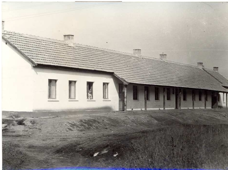
Munkásszállás a Tedeji Állami Gazdaságban 1973-ban, a felújítás előtt (saját gyűjtés)
