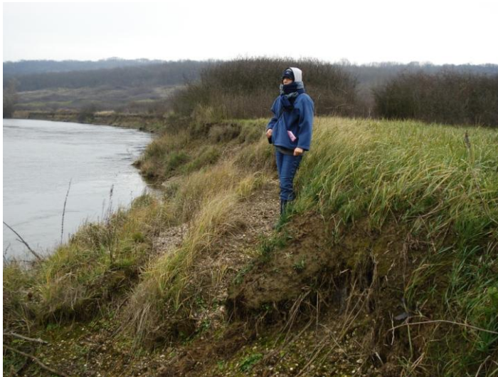
5. kép: „B” típusú pusztulási forma – leszakadt tömbök feldarabolódása Alsódobszánál (saját felvétel)
