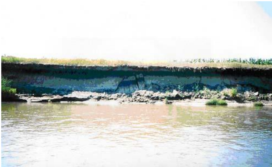
3. kép: „A” típusú pusztulási forma - blokkokban pusztuló partszakasz Nagykinizsnél (saját felvétel)
