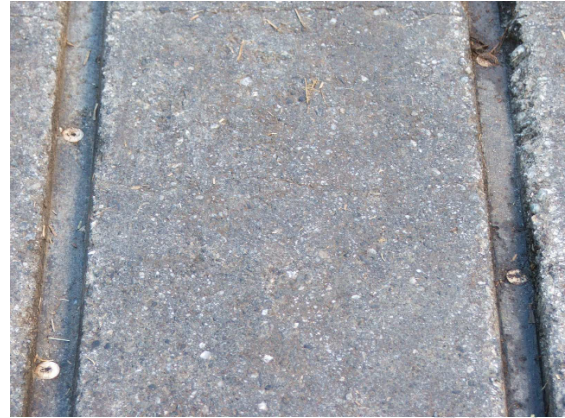
57. ábra: Komposztáló bunker felépítése (a) és a padozatban lévő levegőztető nyílások (b) (Forrás: Gyórfi Júlia)
