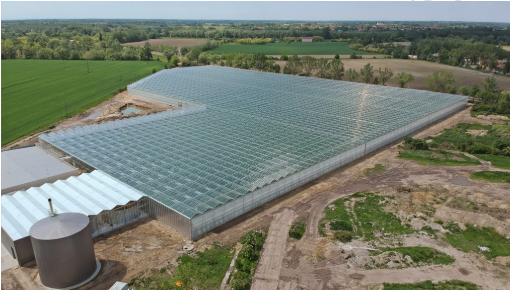
6. ábra Az újonnan felépült 5 ha-os üvegház blokk Győrben
