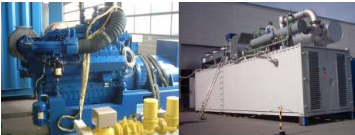
23. ábra: Deutz gyártmányú biogáz-motor a tengelyére szerelt generátorral és blokkfűtőmű egység (Pro2) (saját forrás)
