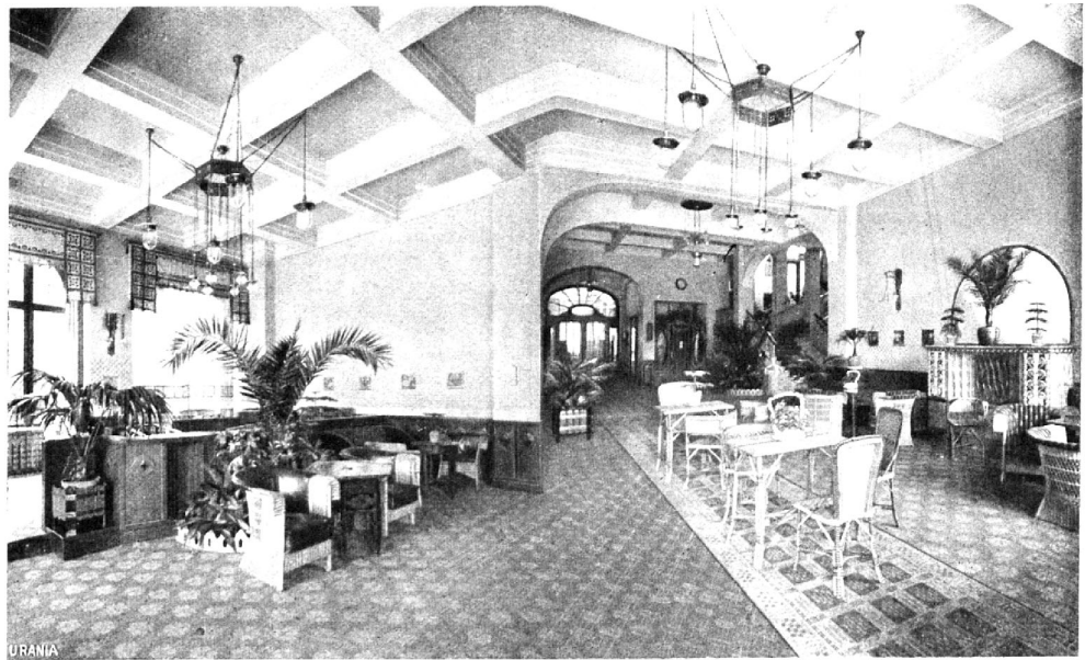
Vestibul Vestibule Lounge Hall
